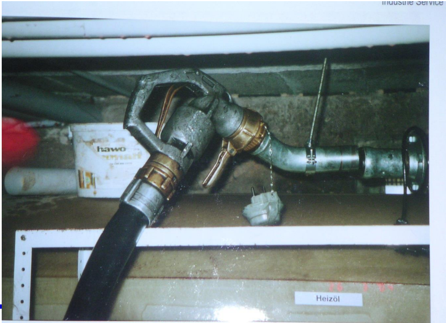
schluessermetur des Füllschlauchs (mit Haltegriff) montiert am Füllstutzen des Tanken
